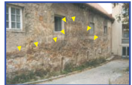
Foto 1: Anomalie der Feuchtesteighöhe über einer Wasserader
