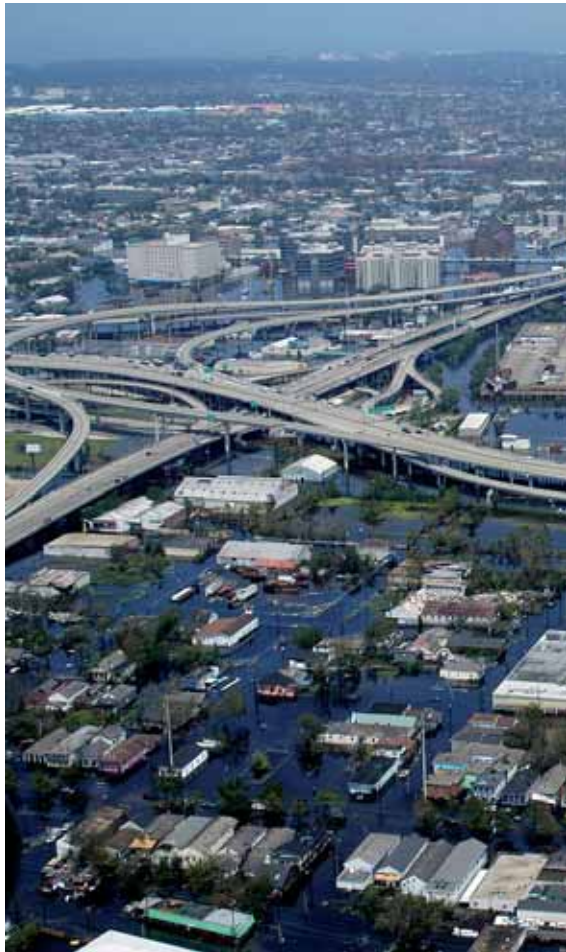
Abb. 2: Der mittlere Wirbelsturm Katrina führte Ende August 2005 wegen des unzulänglichen Küstenschutzes und nicht wegen der Klimaerwärmung zu großen Überschwemmungen in der Stadt New Orleans.
